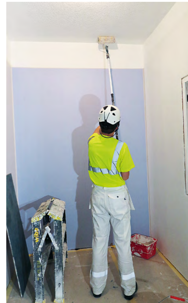
8.22 Sisäkaton maalauksessa on ensin tarkistettava, sulaako ruiskutasoitteipinta veteen.
