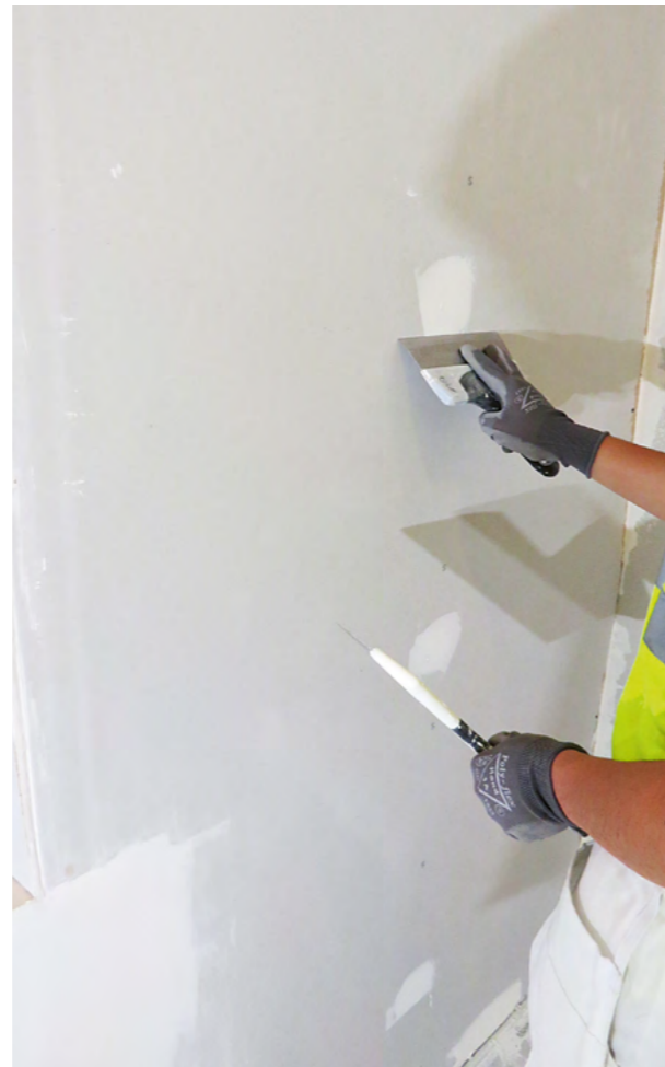
9.14 Seinän kolot ja muut epätasaisuudet kitataan kahta teräslastaa apuna käyttäen.
