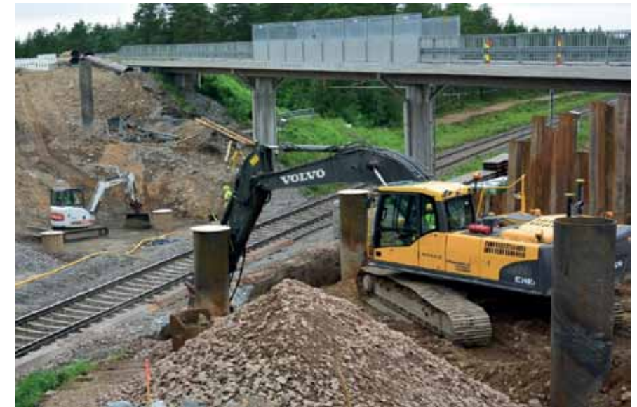
Kuva 1.2. Maarakennusyrityksen tyypillinen palvelu on teiden louhinta- ja maanmuokkaustyöt.
